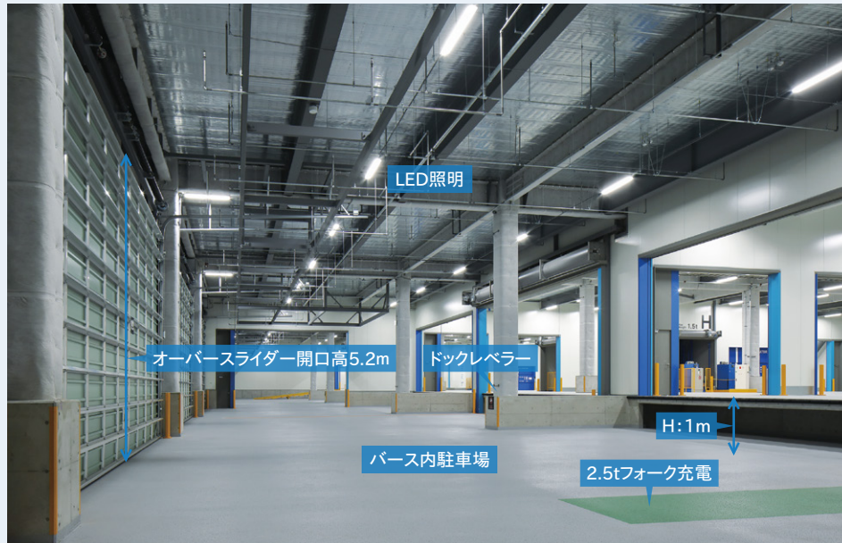
■トラックバース (バース内駐車場)
