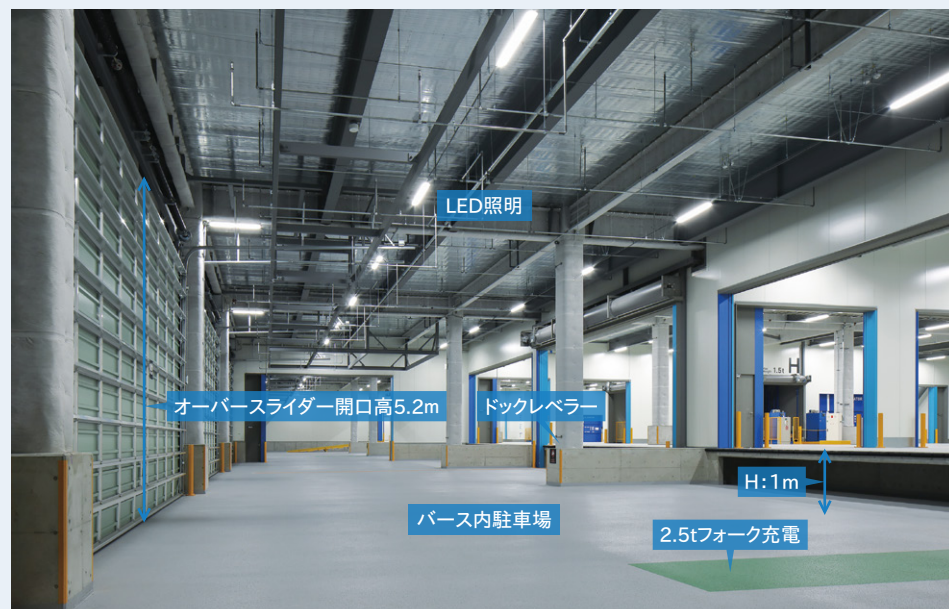
■トラックバース(バース内駐車場)
