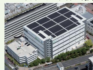
オンサイトで発電・自家消費 太陽光パネル(発電設備容量:0.6MW)
