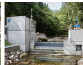
小水力発電(滋賀県高島市)
