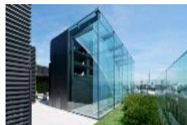
自然換気用ソーラーチムニー
