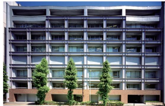
鉄骨ブレースを用いた耐震補強(高樹町センタービル)
