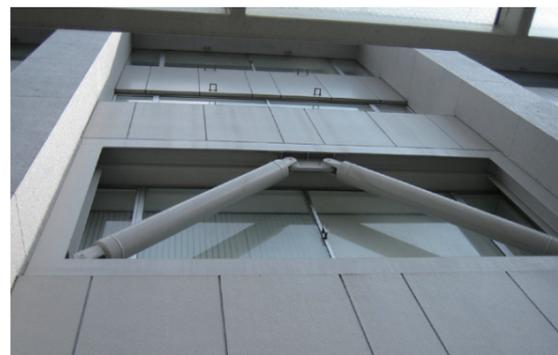
鉄骨ブレースを用いた耐震補強(蒲田富士ビル)
