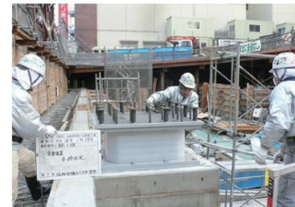
免震装置・積層ゴム取付状況
