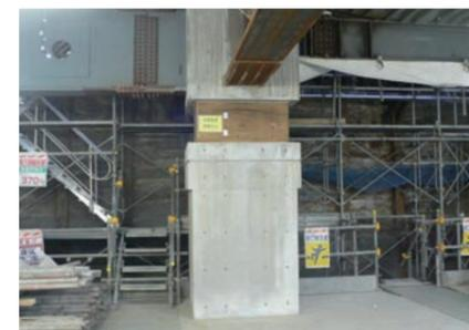
免震装置・積層ゴム施工完了状況
