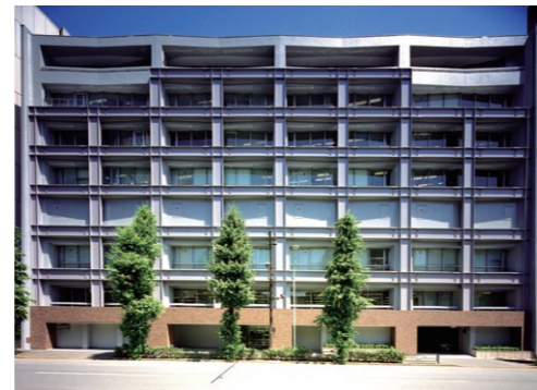
鉄骨ブレースを用いた耐震補強(高樹町センタービル)
