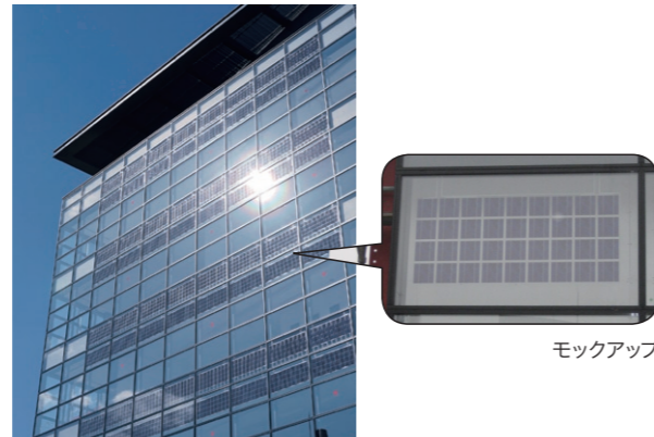
ヒューリック八王子ビル (窓ガラスの上部に太陽光パネルが挟み込まれている)
