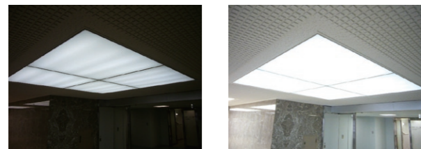
減光実験の様子(ヒューリック大阪ビル)
