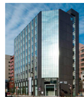
ヒューリック両国ビル
