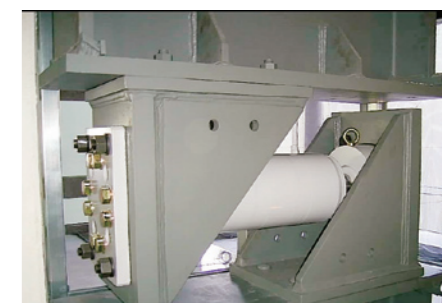
制振部材の例
