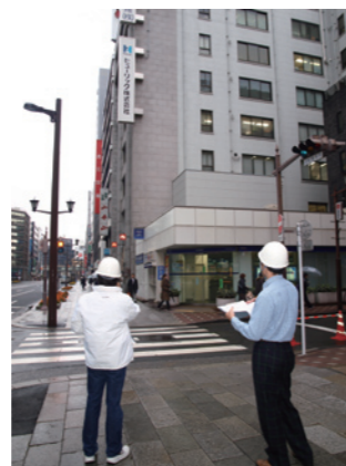
応急危険度判定の様子
