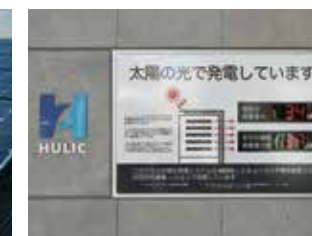
発電量の見える化システム(ヒューリック八王子ビル)
