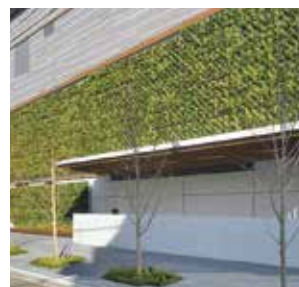
ヒューリック浅草橋ビル(壁面緑化)
