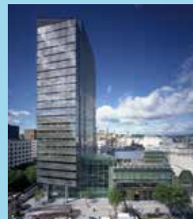
仙台ファーストタワー(2009年6月竣工)
