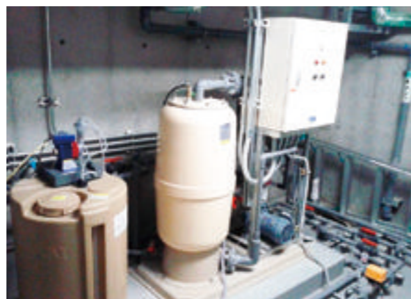
ヒューリック世田谷 雨水再利用装置
