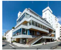
コンバージョン後(商業施設)
