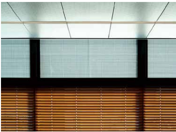
自然採光システム（窓の上部）
