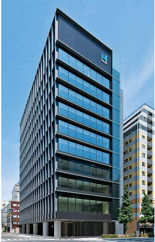
ヒューリック本社ビル
