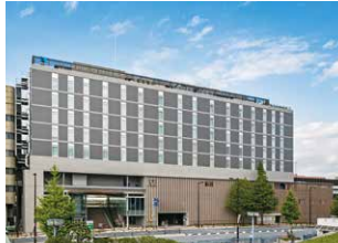
ヒューリック両国リバーセンター
