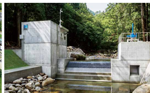
鴨川小水力発電所
