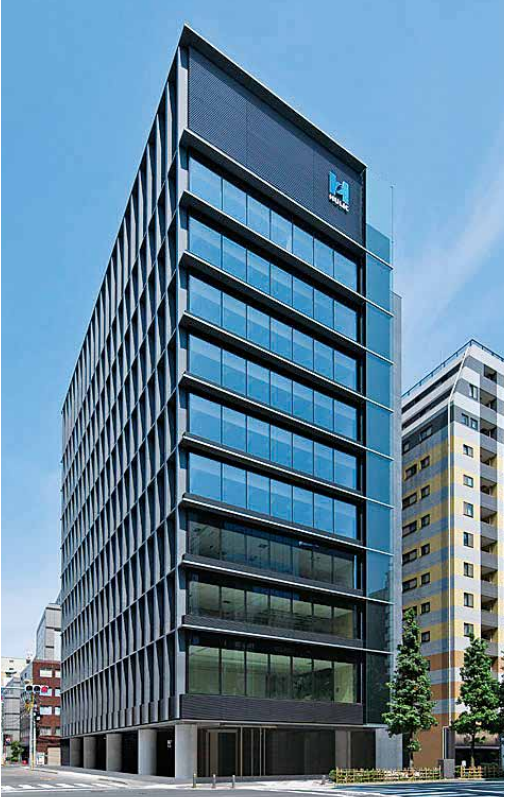
ヒューリック本社ビル
