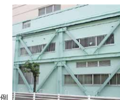
耐震補強事例
