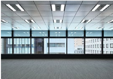
自然採光ルーバーとLED照明(ヒューリック本社ビル)
