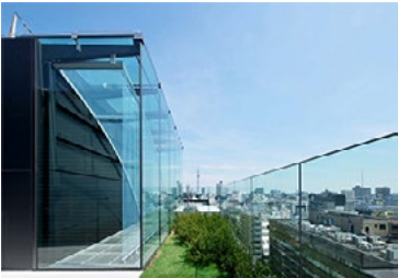
屋上ソーラーチムニー(ヒューリック本社ビル)
