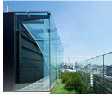
自然採光システム (ヒューリック本社ビル)
