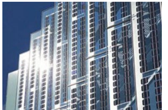
建材一体型の太陽光発電パネル(ヒューリック荻窪ビル)
