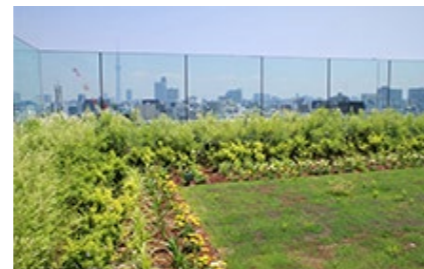
本社ビル増築棟の屋上緑化
