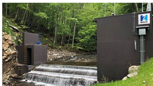
川場谷小水力発電所の取水口
