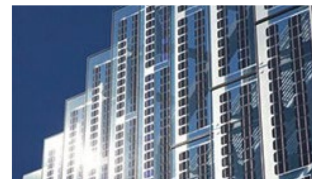
建材一体型の太陽光発電パネル（ヒューリック荻窪ビル）
