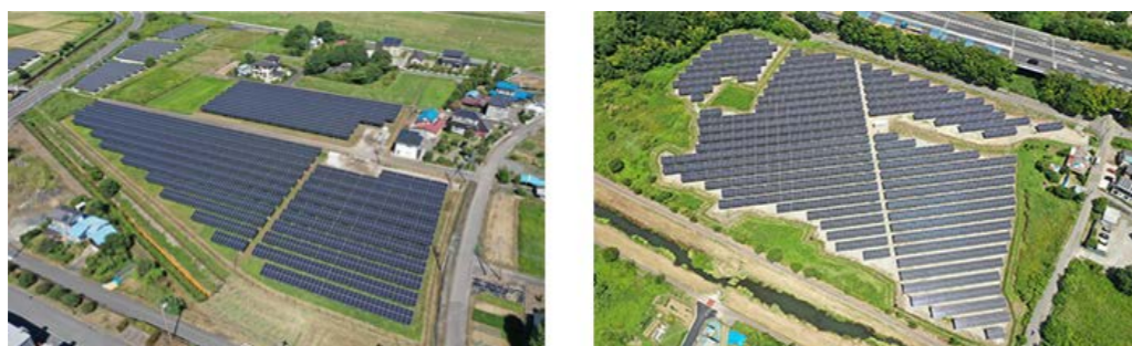
非FIT太陽光発電設備
