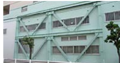
耐震補強の例（LICOPA 鶴見）
