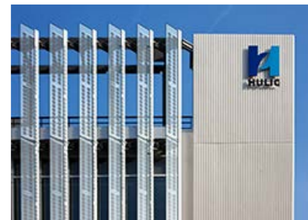
建材一体型の太陽光発電パネル（ヒューリック荻窪ビル）
