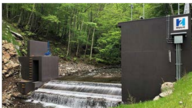
川場谷小水力発電所の取水口
