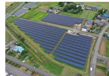
非FITの太陽光発電設備 (埼玉県)
