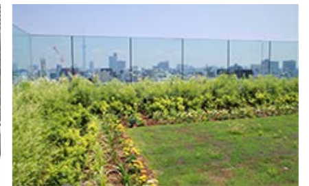
本社ビル増築棟の屋上緑化
