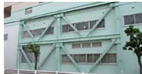
耐震補強の例 (LICOPA 鶴見)
