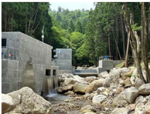
滋賀県鴨川小水力発電所の取水口
