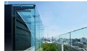
自然換気システム（ヒューリック本社ビル）
