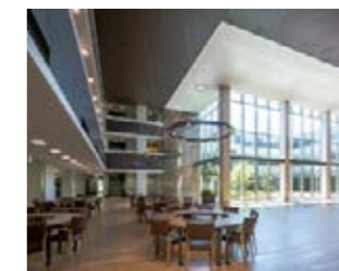
自然換気システムを導入した吹き抜け (ホスピタルメント武蔵野)
