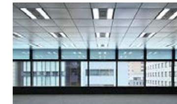
自然採光ルーバーとLED照明（ヒューリック本社ビル）
