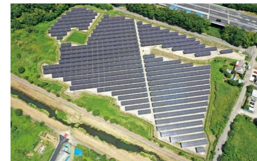
太陽光発電設備 千葉市若葉区
