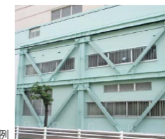
耐震補強事例
