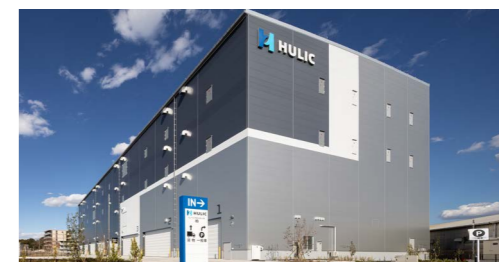
ZEB（Net Zero Energy Building）の開発（ヒューリックロジスティクス柏）
