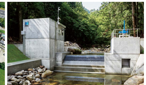
鴨川小水力発電所
