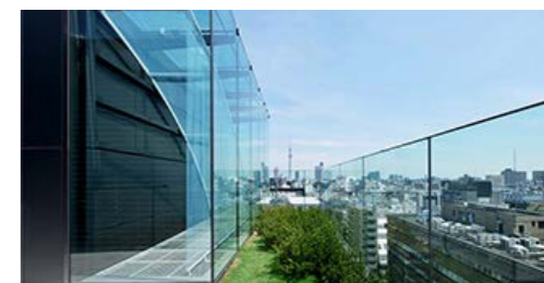
自然換気システム（ヒューリック本社ビル）
