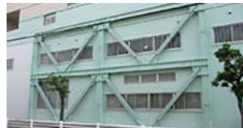
耐震補強の例 (LICOPA 鶴見)
